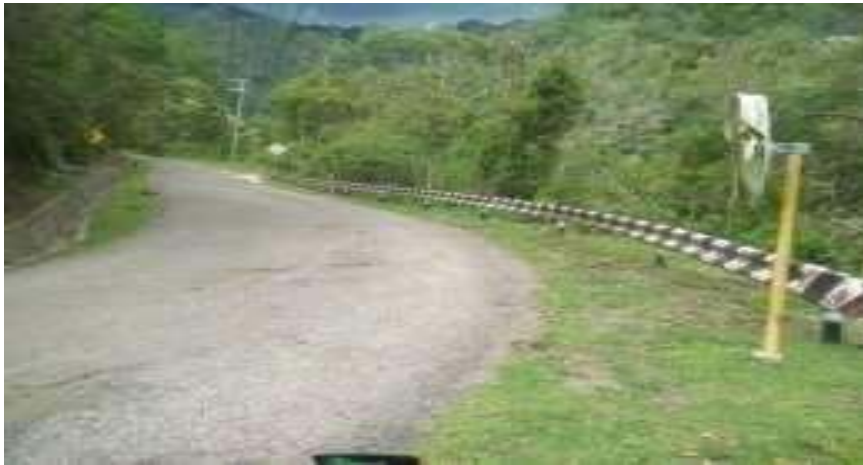
Gamba 25. Pengaman jalan
